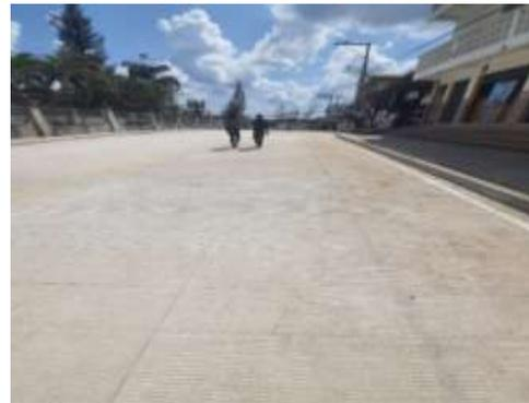
Este proyecto consistió en pavimentar con concreto de 4000 PSI con un espesor de 0.15 m, un total de 1372.20 M2, con bordillos y señalización. El proyecto se encuentra al 100% de avance físico. Contrato No. 013-2021
